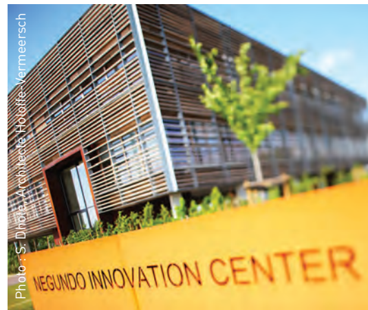
Le bâtiment Negundo (Tournai) est doté de pompes à chaleur réversibles, de panneaux photovoltaïques et deux éoliennes
