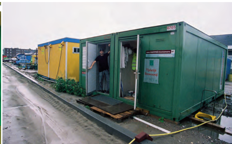
Le placement de conteneurs résidentiels sur les chantiers permet une présence 24h/24 pour contrer le vandalisme.
