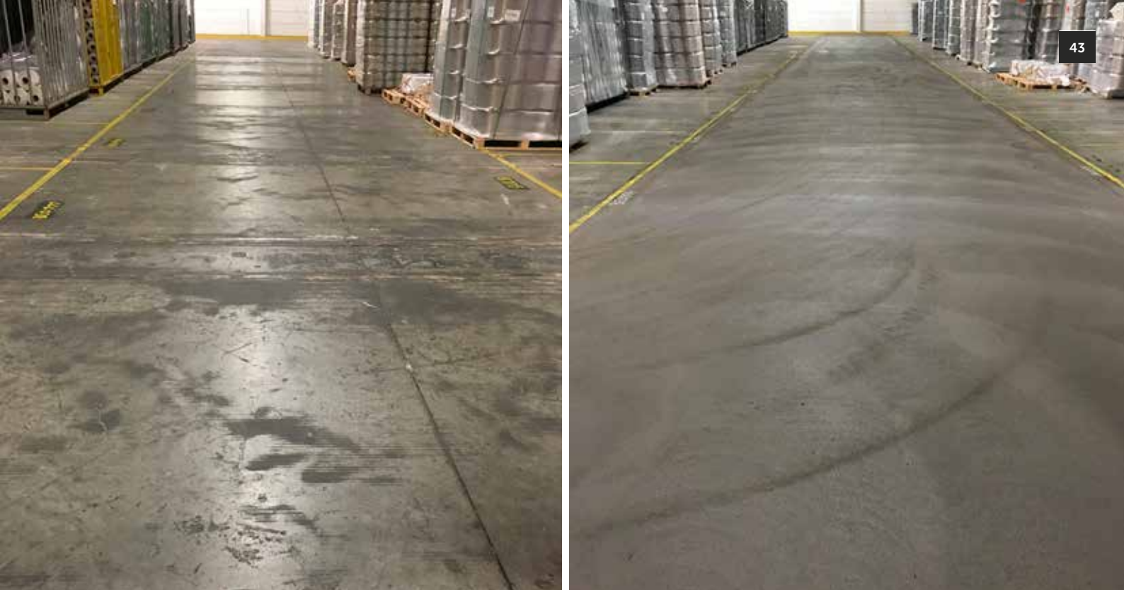
Bij tapijtenfabrikant Balta bleek de Latexfalt vloer de geschikte oplossing voor de in slechte staat verkerende gangpaden. Foto's voor (links) en na (rechts) de behandeling
